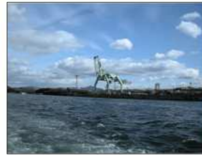
⑩新日鐵・ガントリークレーン
