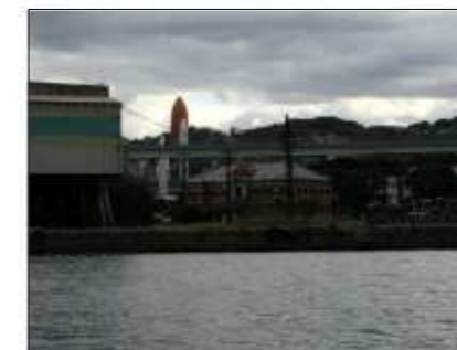
⑪八幡製鉄・旧本舎屋
